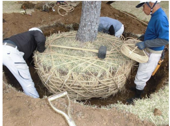
No.9H黒松 候補2 根巻き状況写真
